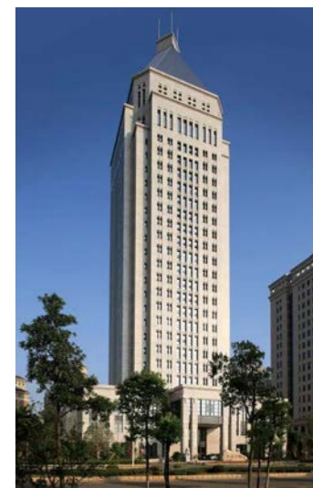
※ 江西省森林防火预警监测总站大楼（鲁班奖工程）
